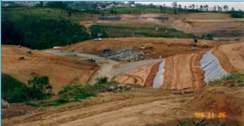
Aterro em Operação
